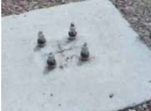
Base en béton
